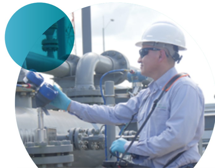
Colaborador Estación de compresión de gas Villavicencio
