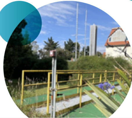
Estación de compresión de gas La Sábana
