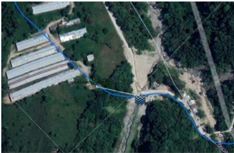
Figura 4. Cruce actual del Gasoducto Apiay – Villavicencio – Bogotá con la Quebrada El Aguardiente.
