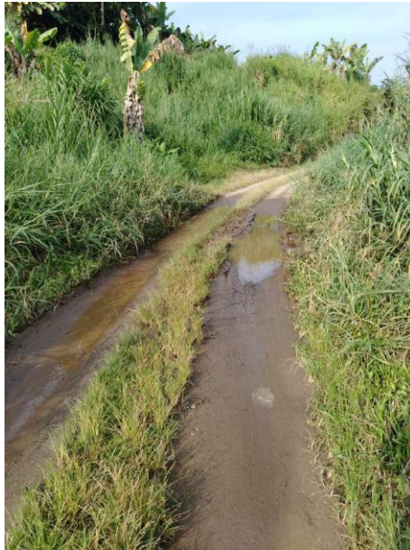
Fotografía 1/4 Punto de cruce de agua sobre vía de acceso
