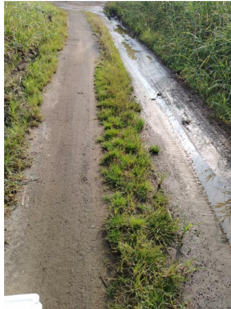
Fotografía 2-5 Punto de cruce de agua sobre vía de acceso
