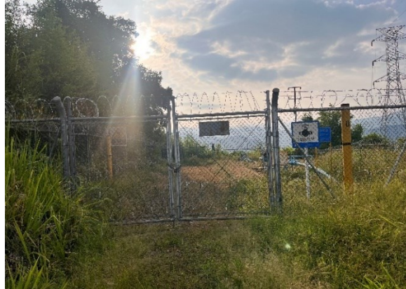
Fotografía 3-8 Grupo de uso Infraestructura (Uso actual Industrial asociado a la cobertura Explotación de hidrocarburos)
