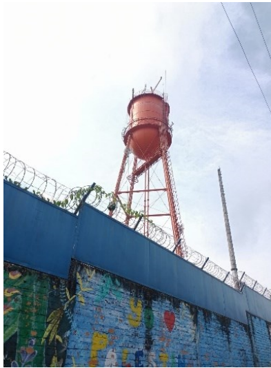
Fotografía 3-50 Acueducto Municipio de Palestina
