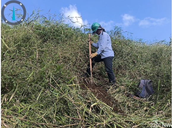
Fotografía 3-90 Excavación pozos de sondeo
