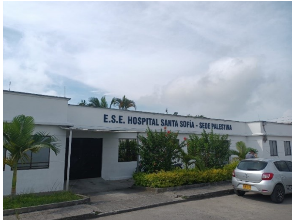
Fotografía 3-55 Hospital Departamental Santa Sofía - Municipio de Palestina
