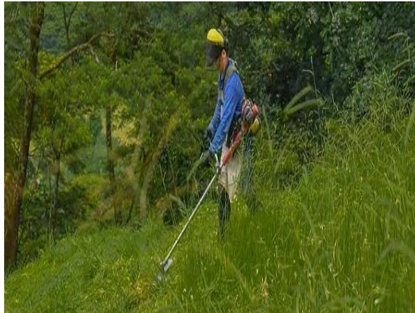
Fotografía 4-10 Ejemplo del proceso de limpieza en el área a rehabilitar
