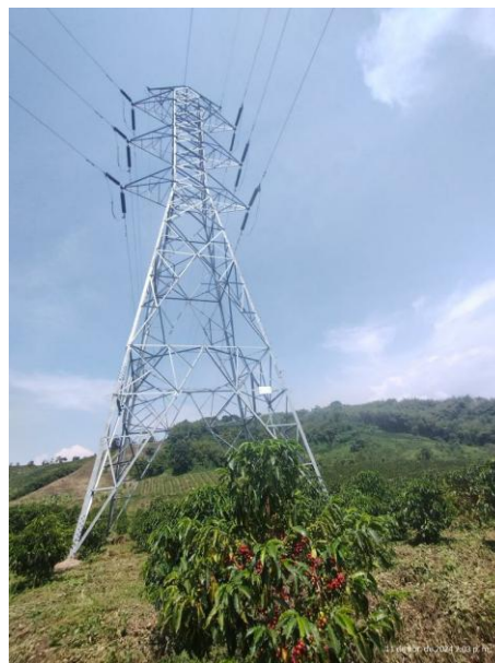
Fotografía 5-11 Línea eléctrica de baja tensión
