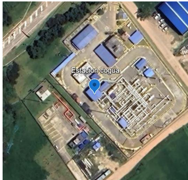
Ilustración 1. Centro Operacional Cogua
